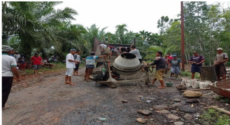
Gambar 3. Proses pencampuran semen, pasir, kerikil dan air
