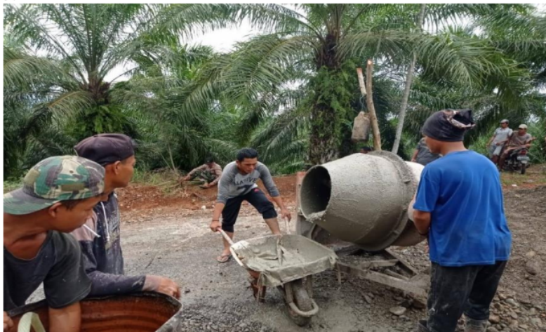
Gambar 5. Proses perbaikan Jalan
